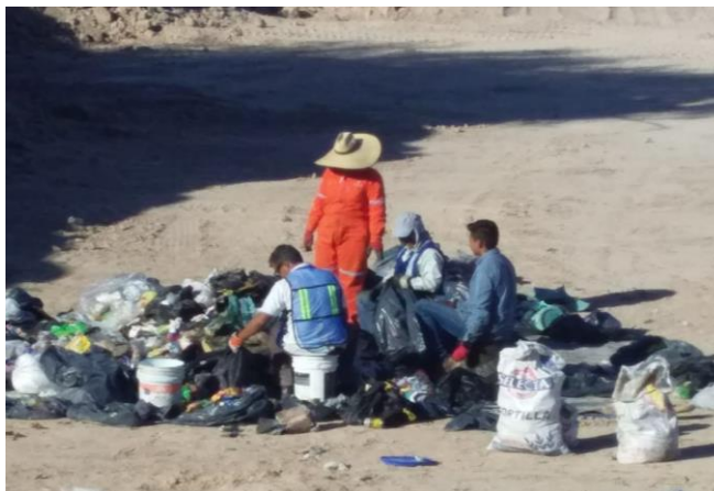
Figura 10. Método de separación y clasificación practicado por ECOCE. 08 de diciembre 2019, DGMA.
