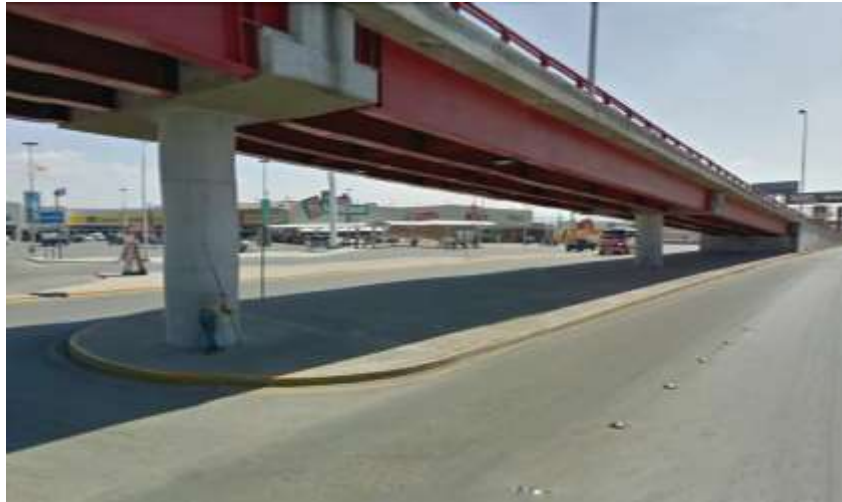
Imagen 185. Vista actual puente L. D Colosio en Matamoros
