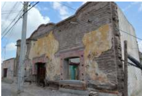
Imagen 84. Casa de adobe en muy malas condiciones en conservación en el centro de Matamoros.
