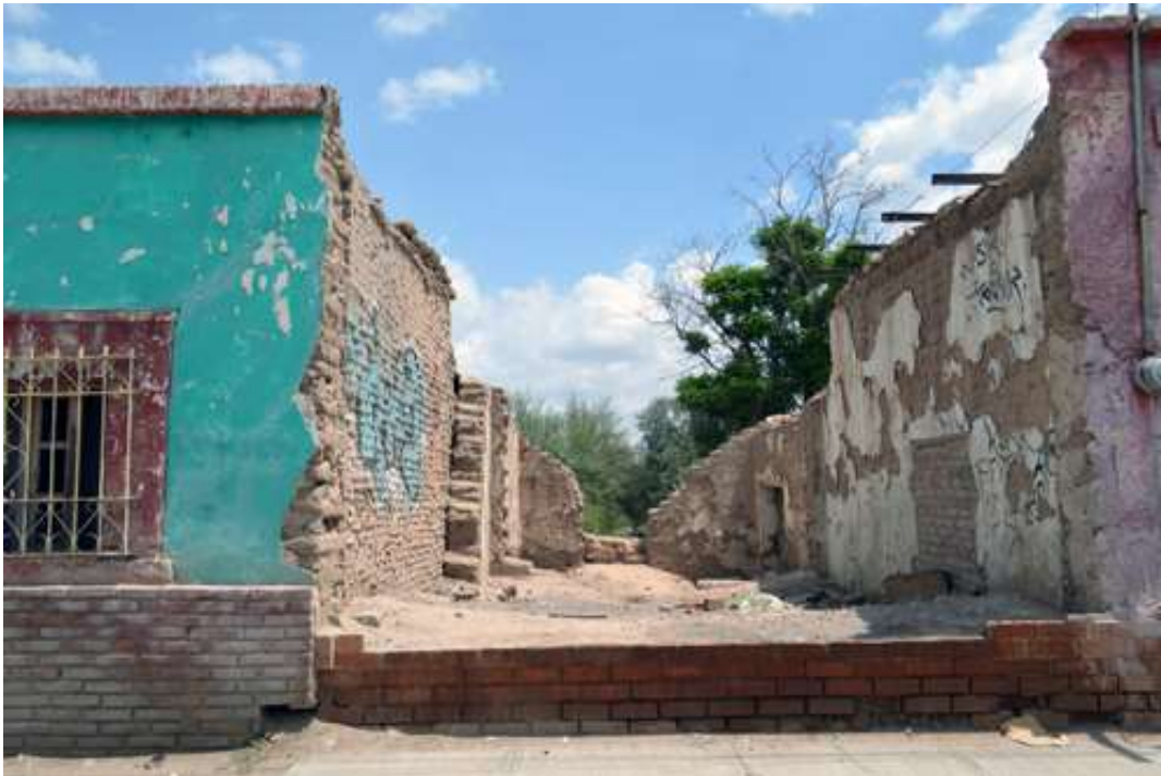
Imagen 72. Casas de adobe en malas condiciones y predio abandonado en el centro de Matamoros.
