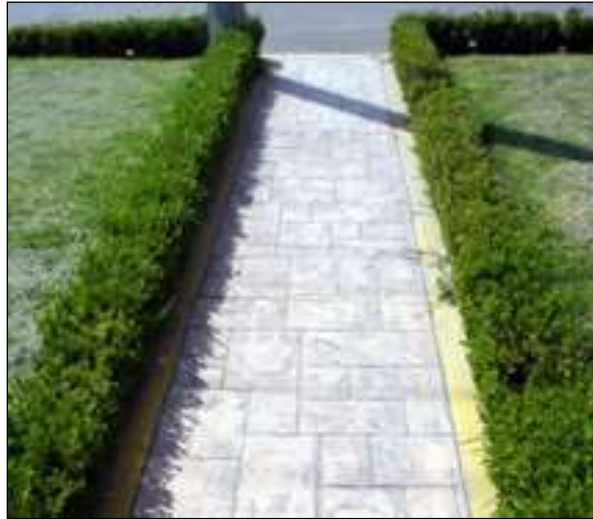
Imagen 433. Banqueta de concreto estampado
