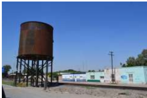
Imagen 96. Tanque junto a las vías del tren de Gómez Palacio a Francisco I. Madero.
