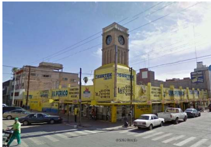
Imagen 45. Estado actual de la Torre del Reloj Simón Lack.
