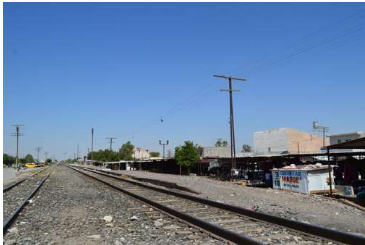
Imagen 105. Vías del con asentamientos informales cercanos en Francisco I. Madero.
