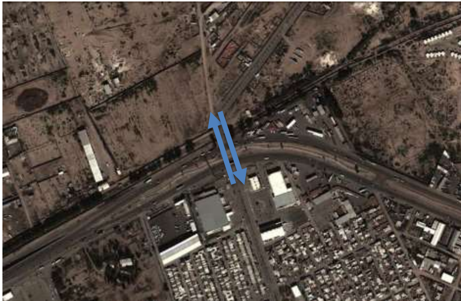
Imagen 626. Puente Periférico-Francisco Villa
