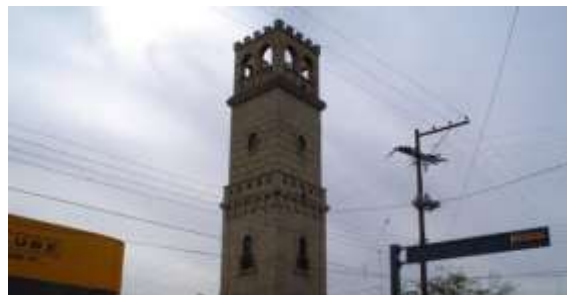
Imagen 95. Torre de la fundidora Número 3 de Torreón.
