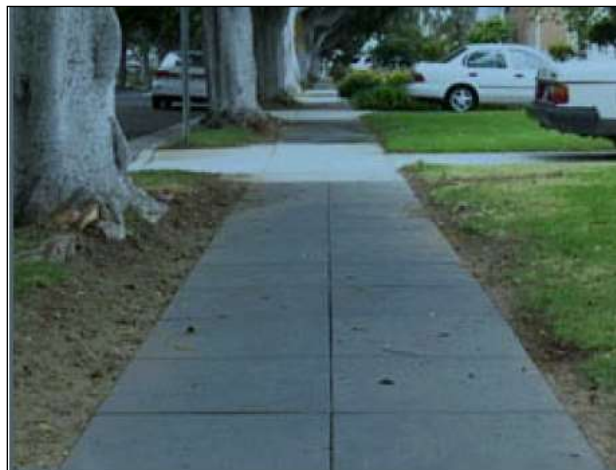
Imagen 432. Banqueta de concreto
