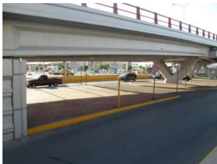
Imagen 192. Vista actual del puente Revolución y Saltillo 400
